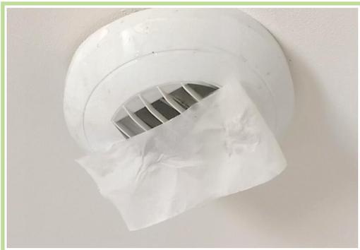
Pour rappel, les entrées d'air se situent dans les pièces sèches (séjour, chambres) et les extractions au niveau des pièces humides (cuisine, salle de bain, toilettes, buanderie).
