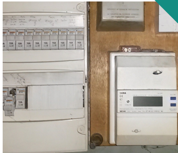
Compteur (et tableau) électrique
