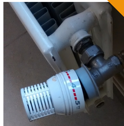
Robinet Thermostatique (abîmé)
