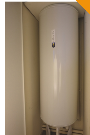
Chauffe-eau électrique cumulus
